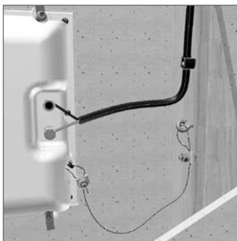
Stahl-Fallschutzdraht, max 30cm/10"
